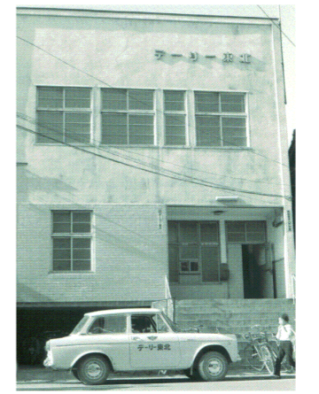
1959(昭和34)年9月に完成した新社屋(八戸市番町)
